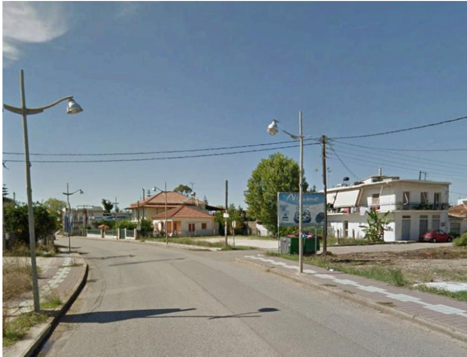
Εικόνα 2: Ιστός φωτισμού στην οδό Αντ. Πετραλιά (Αμαλιάδα) με λαμπτήρα τύπου Na 70W
