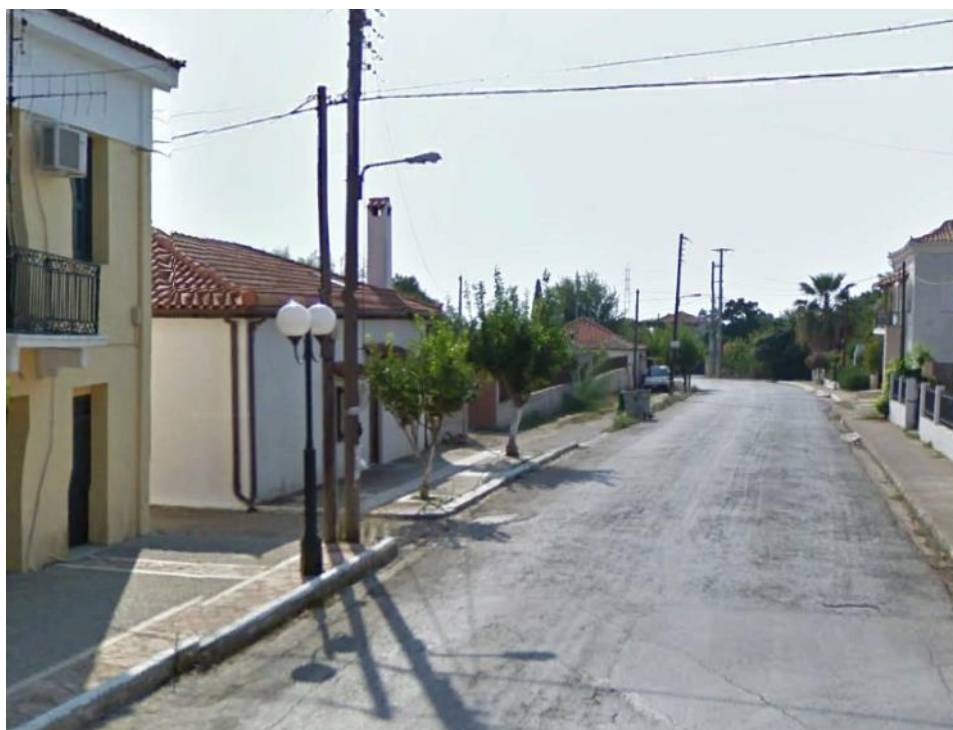
Εικόνα 7: Ιστοί φωτισμού στον Οικισμό Καρδαμά με δύο λαμπτήρες τύπου CFL 23W (ύψος 3,0) και λαμπτήρα τύπου Na 250W (ύψος 6m)
