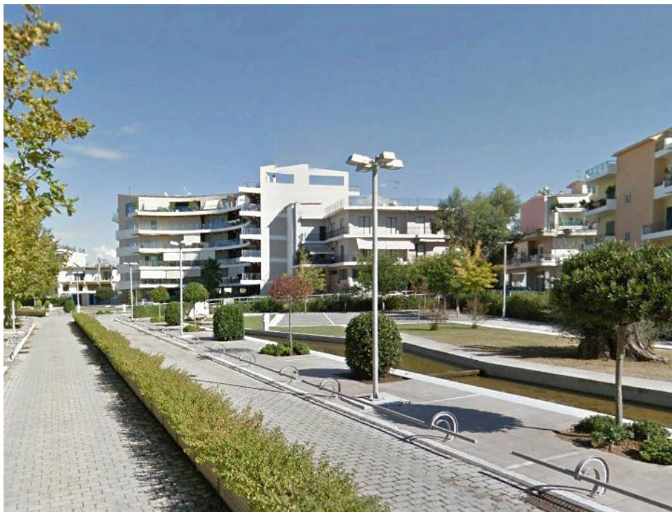
Εικόνα 5: Ιστός φωτισμού στην οδό Πλαστήρα (Αμαλιάδα) με λαμπτήρα τύπου ΗQI 400W
