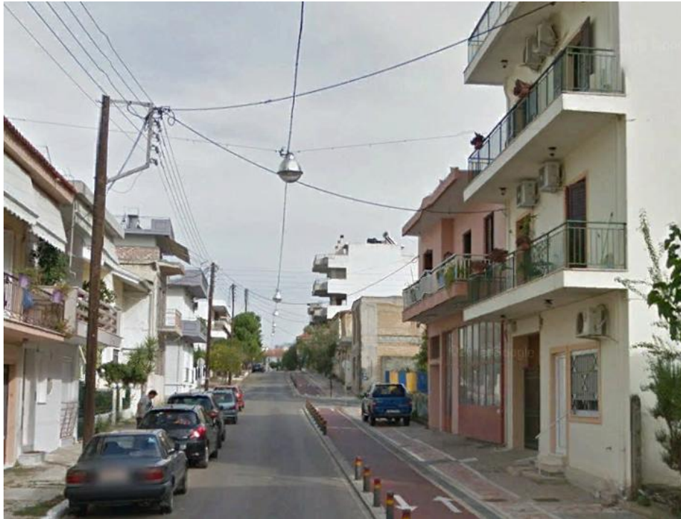
Εικόνα 4: Αξονικός φωτισμός στην οδό Καλαβρύτων (Αμαλιάδα) με λαμπτήρα τύπου Na 150W
