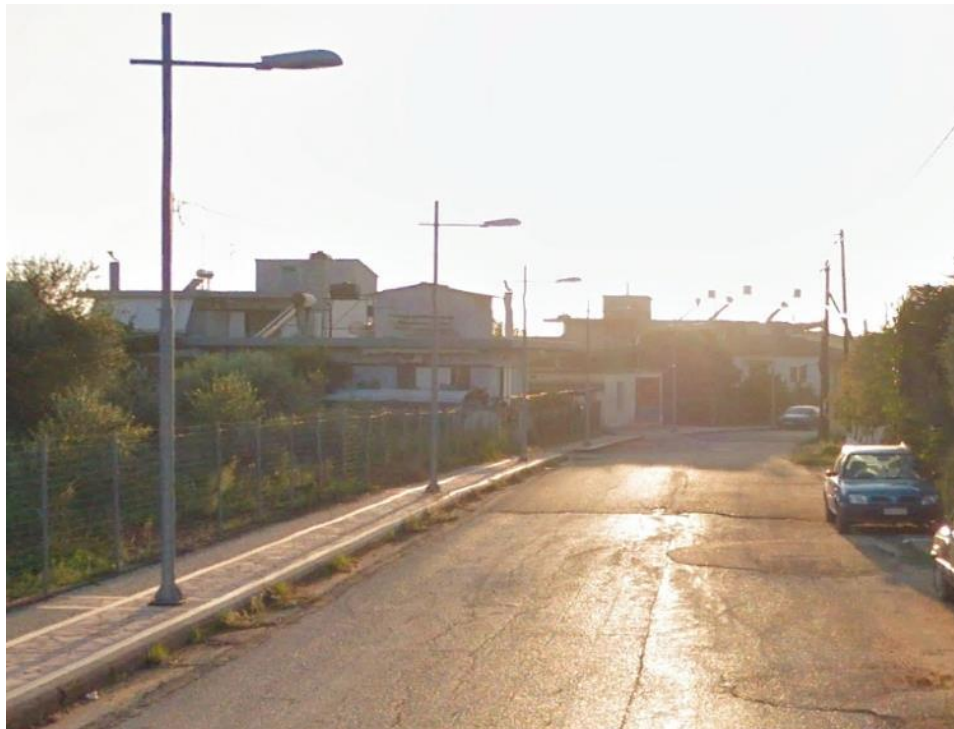
Εικόνα 3: Ιστός φωτισμού στην οδό Δροσίνη (Αμαλιάδα) με λαμπτήρα τύπου Na 250W
