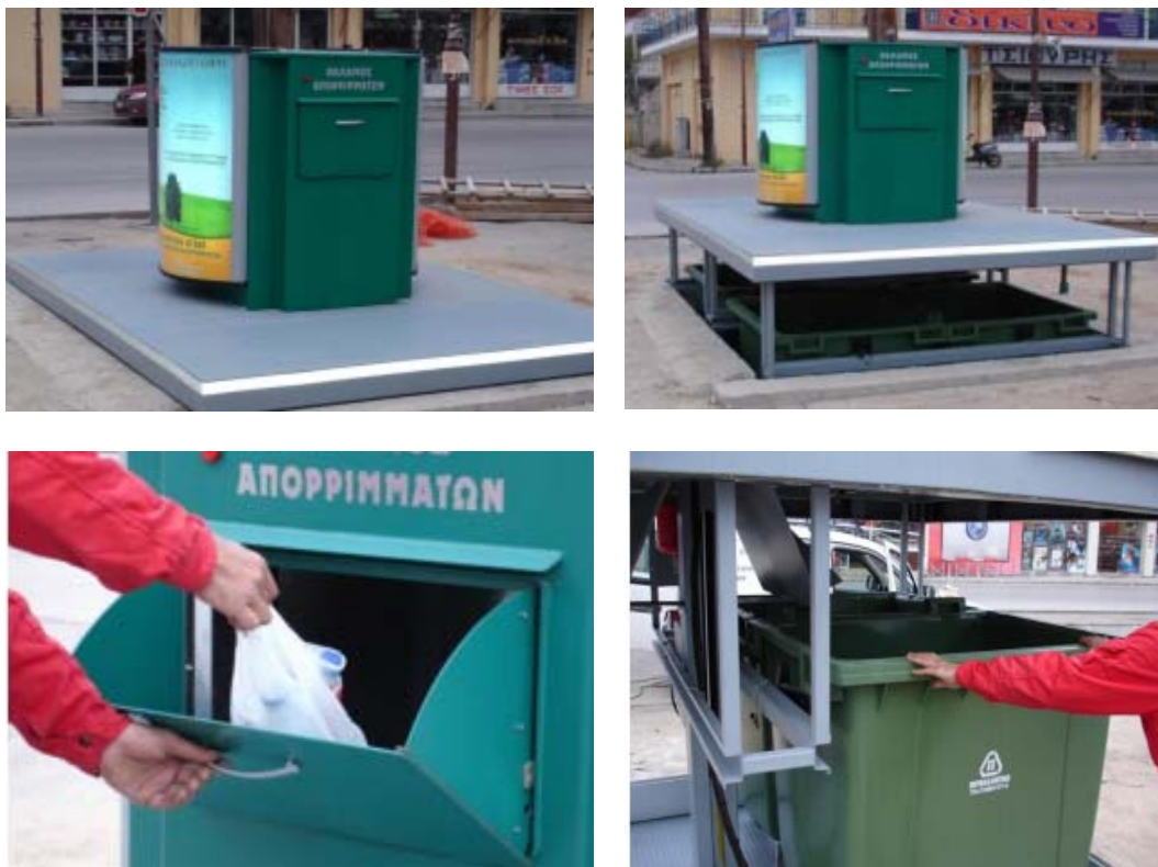
Εικόνα 45: Υπόγειοι κάδοι (ενδεικτικές φωτογραφίες)
